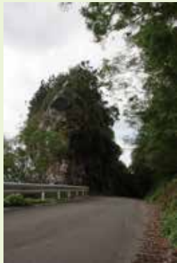
茅打ちバンタ くり抜かれた切通しの岩。バスが通っていたとは 信じられなかった。
