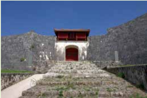
継世門 正殿の北東にある裏門。
